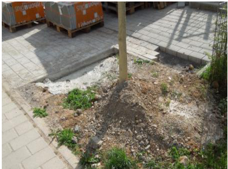
Abbildung 2: Weiß-graue Beläge als Hinweis auf Fremdstoffeintrag. Hier: Zement
